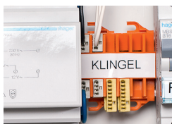
Exemple d'application dans une installation de sonnette – Fixation sur rail DIN 35
